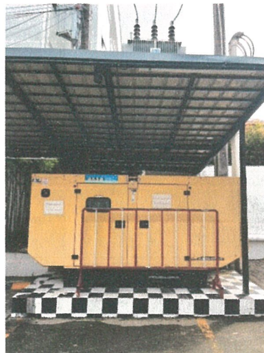
รูปภาพที่ 2.18 เครื่องสำรองไฟฟ้า (Generator)
