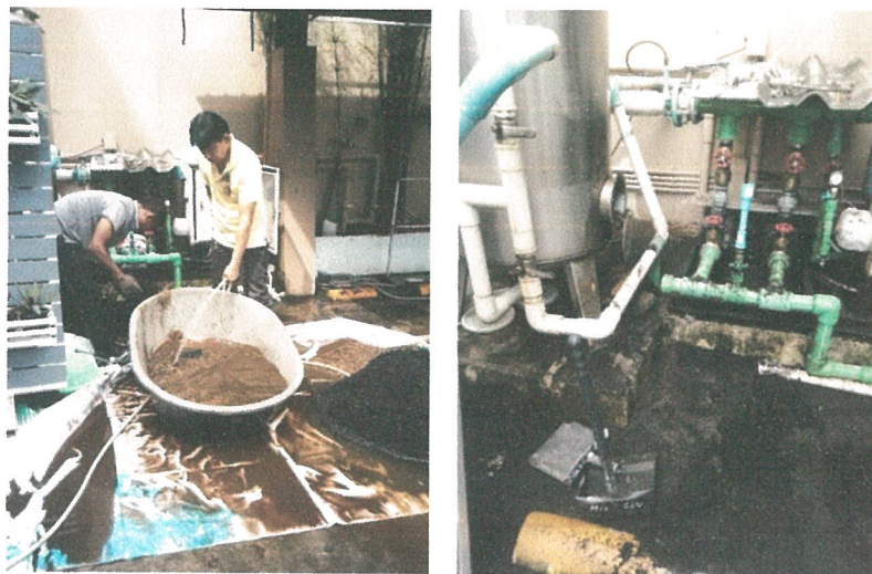
รูปภาพที่ 2.27 การล้างถังเก็บน้ำ
